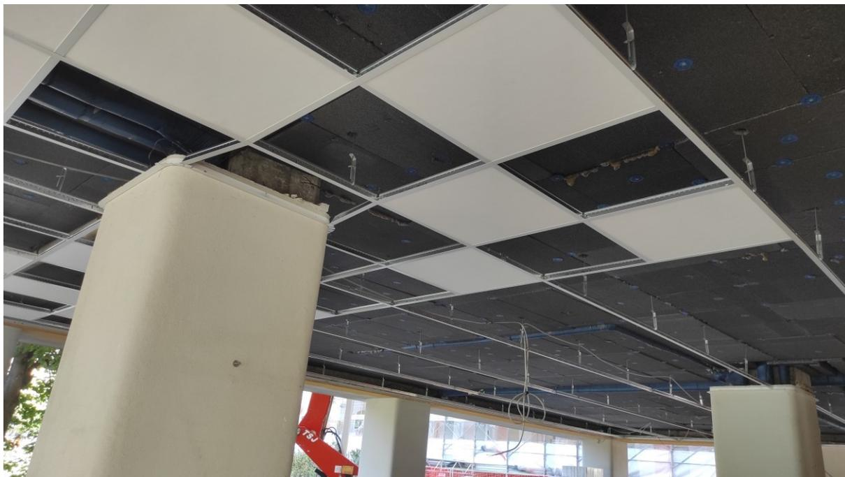
Il tecnico Knauf ha prescritto la posa di un punzone ogni 10 mq di controsoffitto con funzione di controventatura.
